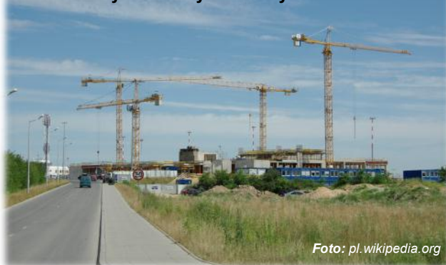
Port Lotniczy im. Władysława Reymonta w budowie
